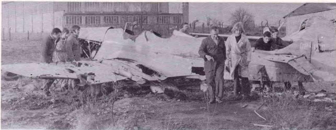
▲ Démontage de l'épave du Miles Magster ▲ à Gent-St-Denijs.
