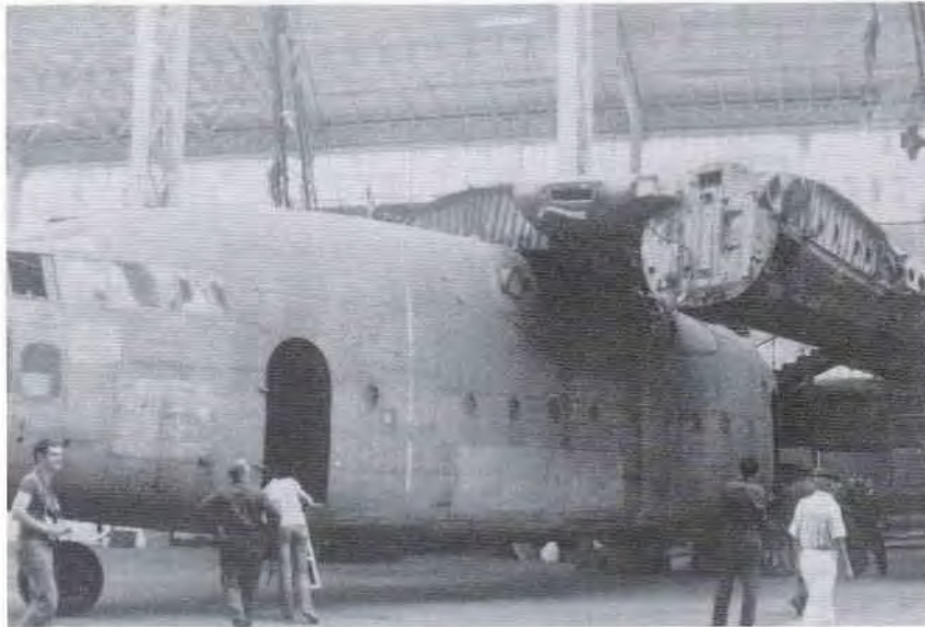
▲ Démontage du « plan central » du C.119. Demontieren van het centrale gedeelte van de C.119.
