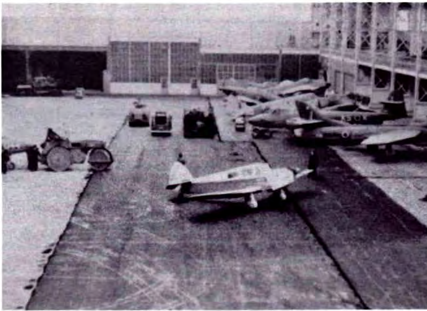
▲ Victorie! On procède à l'asphalage du sol. Viktorie! De grond wordt geasfalteerd.
